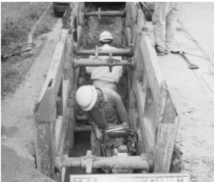
施設設備が急がれる下水道工事
