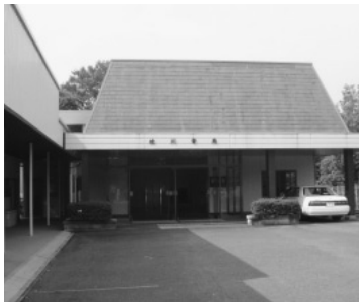
築後38年が経過した綾川斎苑
