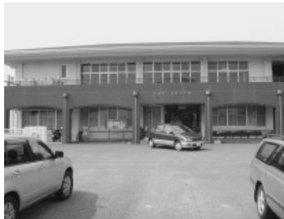
エレベーター設置予定の滝宮公民館
