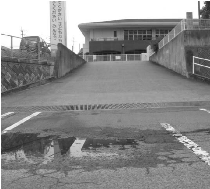
舗装を行う滝宮公民館付近の駐車場
