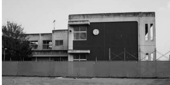
改修工事が始まった旧羽床上小学校
