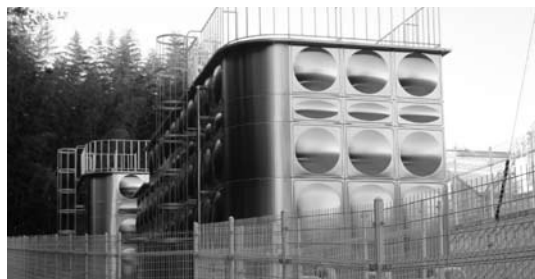
完成している綾上中区排水池（粉所）
