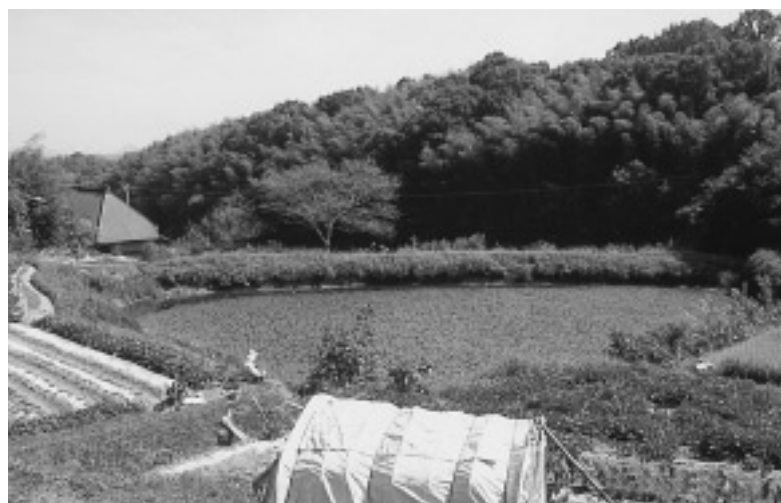
老朽化したため池
