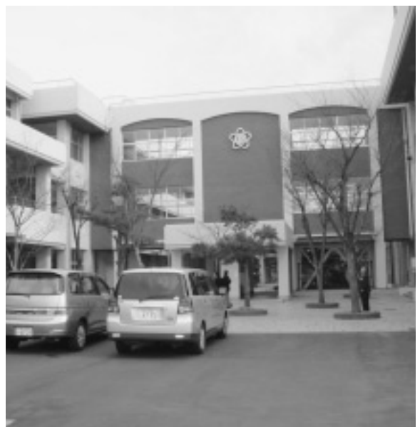
耐震補強が完了した昭和小学校
