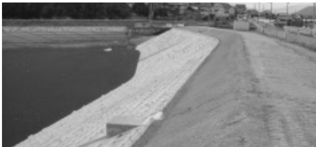
改修工事が終わった庄屋池 (陶地区)
