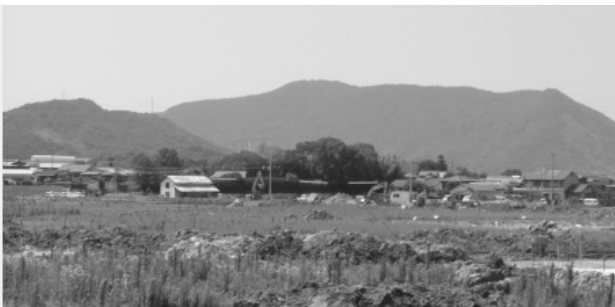
造成工事の進むイオン建設地(萱原地区)
