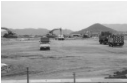
造成工事中の昭和地区保育所
