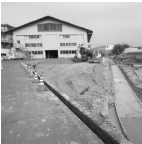
工事中の町道向原上線
