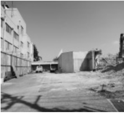
解体中の旧陶病院
