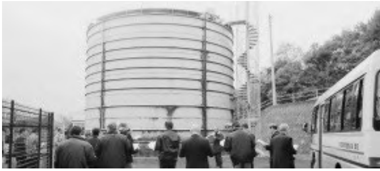
現地踏査の様子（生子配水池）
