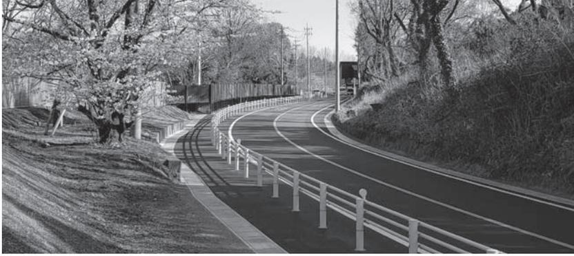
通学路の交通安全対策として設置されたガードパイプ(県道府中造田線)
