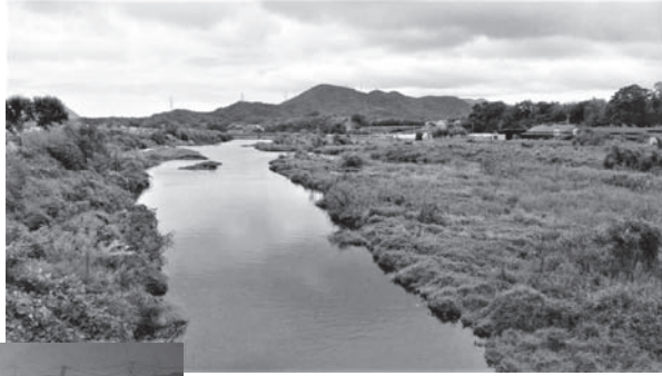
河川内の伐採後も生き茂る雑木
