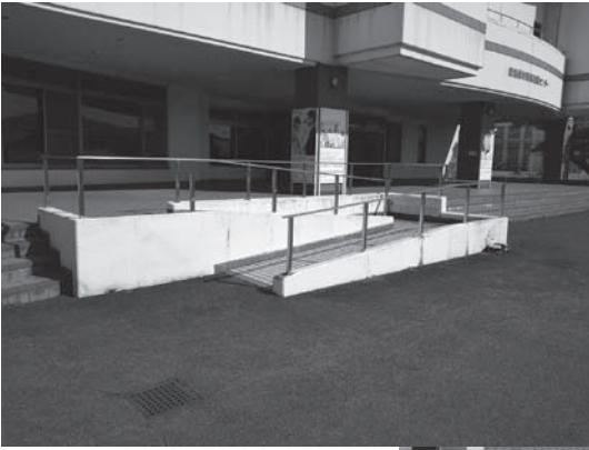
綾南農村環境改善センター 入口スロープ
