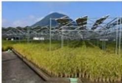
一時転用許可を受け、農地に簡易な構造でかつ容易に撤去できる支柱を立てて、上部空間に太陽光を電気に変換する設備を設置し、**営農を継続しながら発電を行う取組**です。
