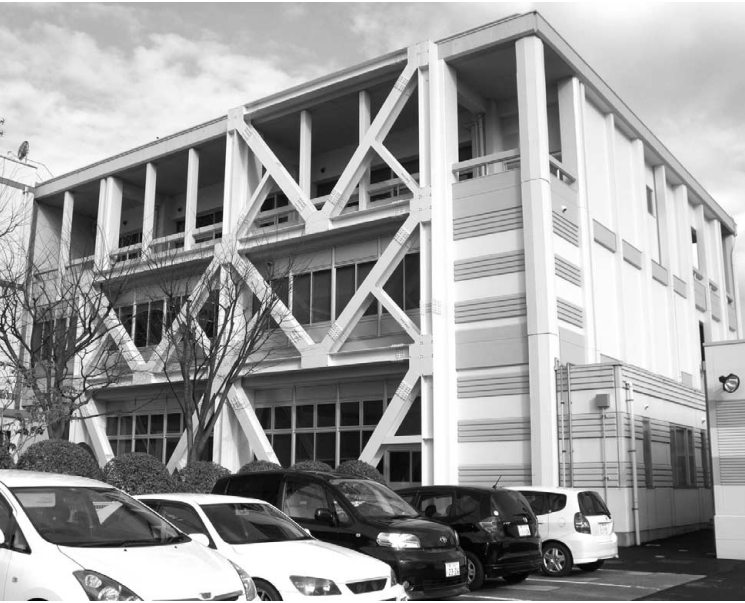
耐震工事が完了した本庁舎
