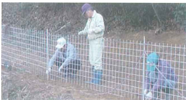
集落ぐるみで周辺林地を伐採しイノシシ防護柵を設置
