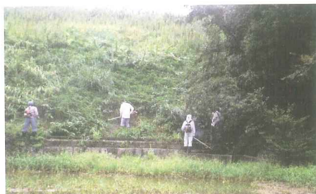
共同作業による堤防の草刈
