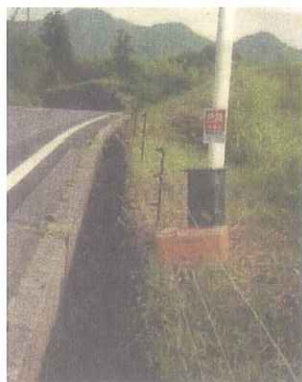
鳥獣害防止柵の設置状況
