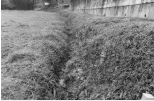
未整備の農業用水路
