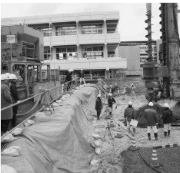
綾南中学校の杭打ち工事
