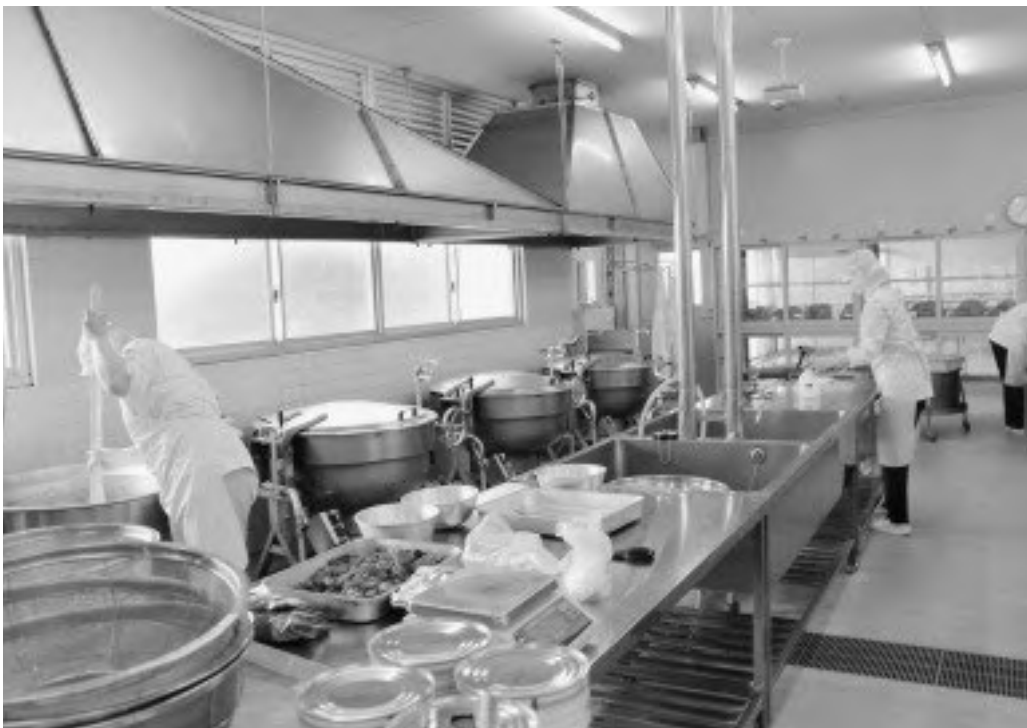
ドライ化改修予定の給食調理場（滝宮小学校）
