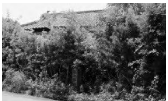
草木生い茂る空き家
