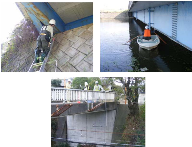
図 3.1 定期点検の様子
