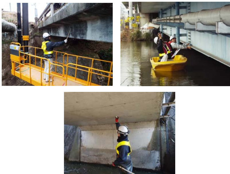
図 3.1 定期点検の様子
