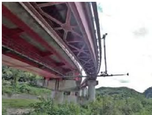
点検ロボットの使用イメージ
