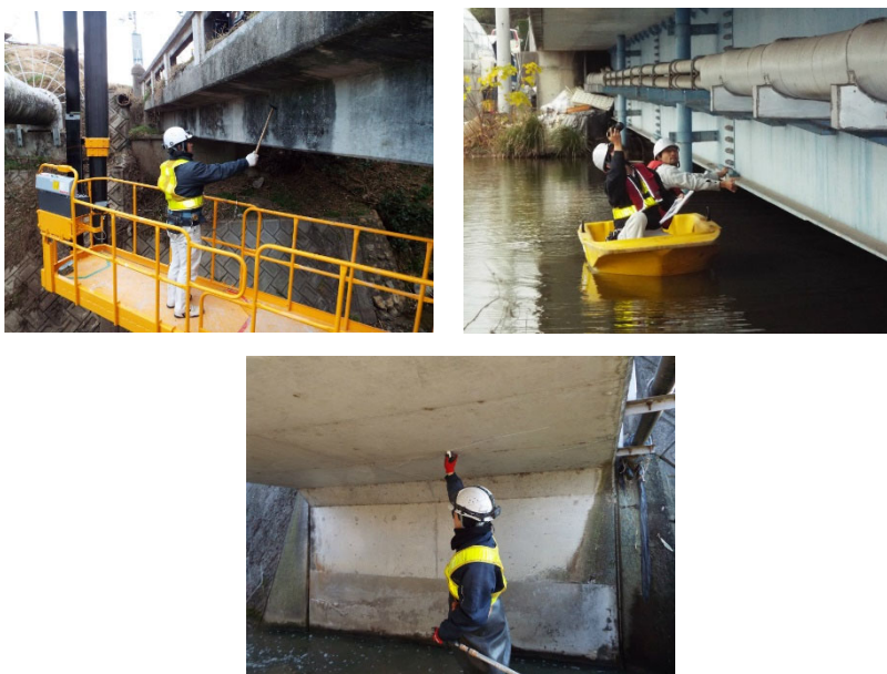
図 3.1 定期点検の様子
