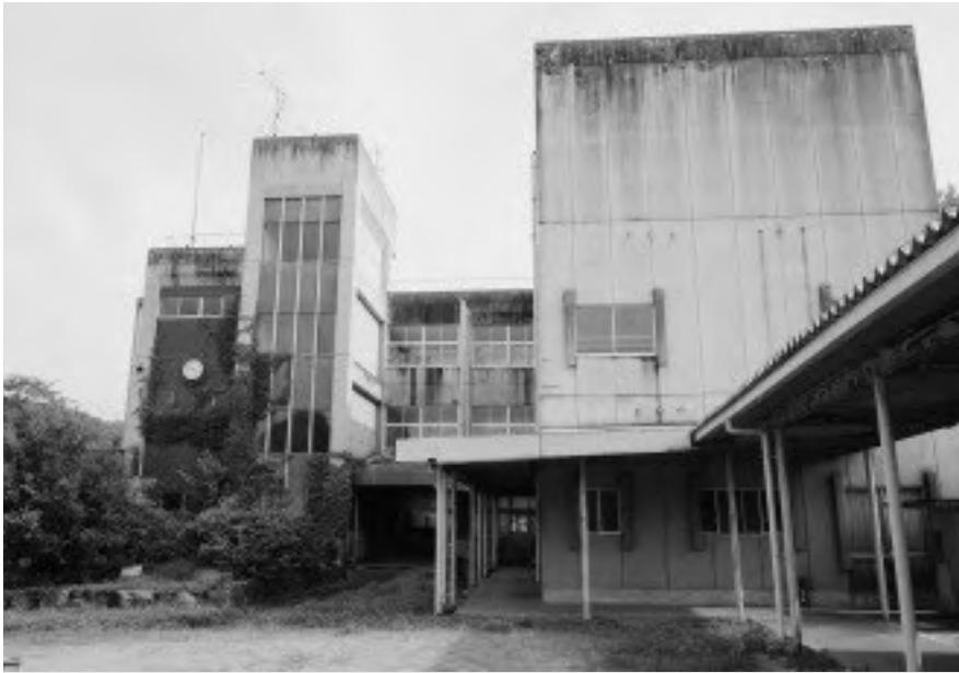
耐震性が無いため活用が難しい校舎棟（旧西分小学校）
