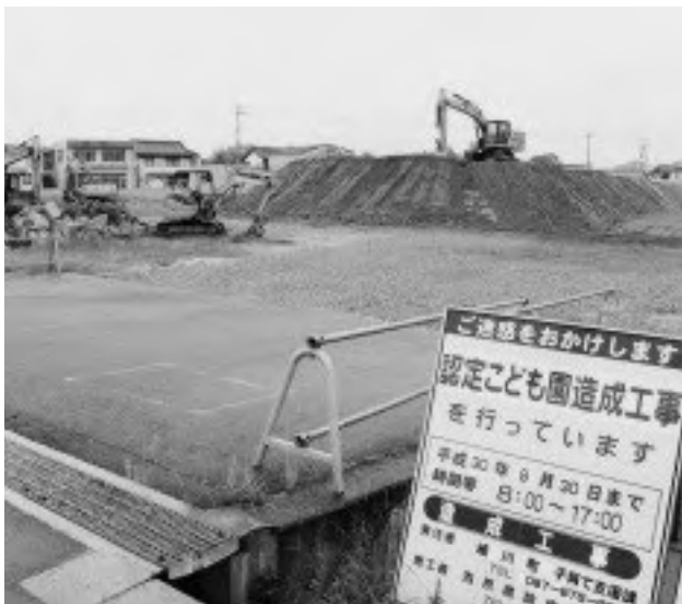
造成工事中の滝宮認定こども園（仮称）予定地
