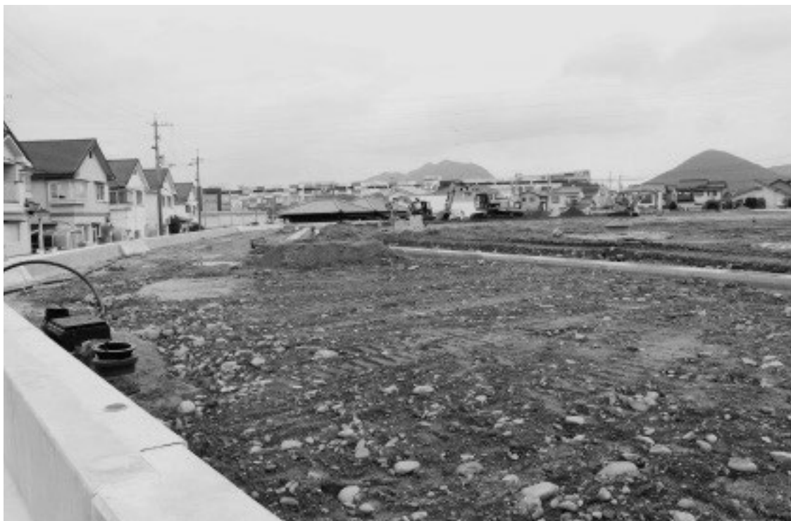
滝宮認定こども園（仮称）造成工事
