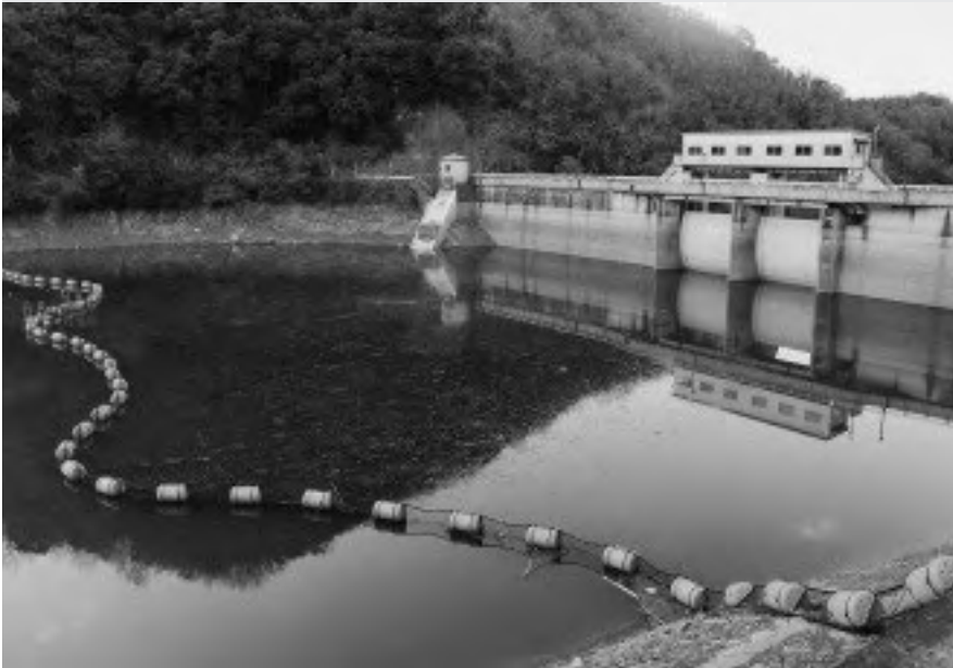
住民が生活用水として利用している長柄ダム
