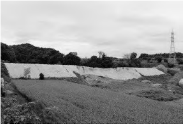
改修予定の奥池堤防（滝宮地区藤尾）
