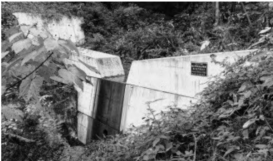
土砂災害防止に活躍する治山ダム
