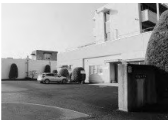
香川県広域水道企業団綾川事務所（綾川町北）
