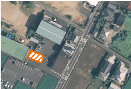
防災倉庫東側
