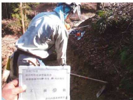
（作業歩道整備施工中の様子）
