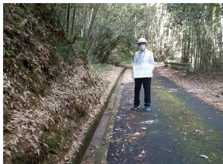
側溝清掃竣工（宮ノ奥）
