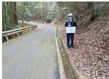
側溝清掃竣工（信常）
