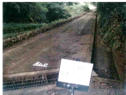
側溝清掃竣工 (宮ノ奥線)
