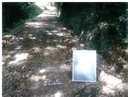
側溝清掃着工前 (宮ノ奥線)
