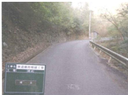
側溝清掃竣工（信常）
