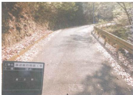
側溝清掃着工前（信常）
