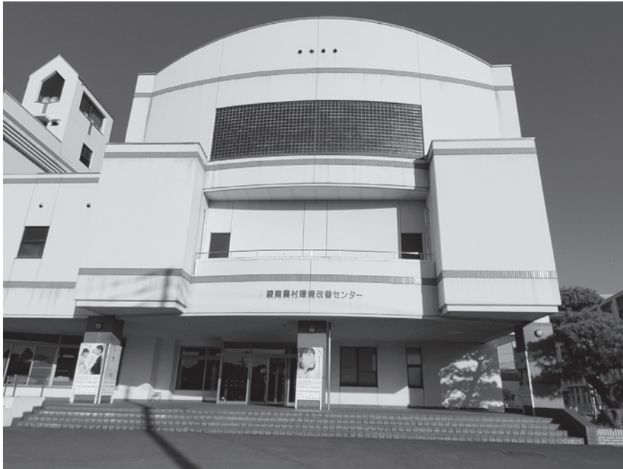
1階の空調機を修繕する綾南農村環境改善センター
