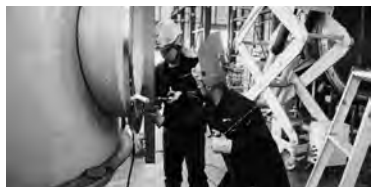
熱交換器に部品を取付ける作業
