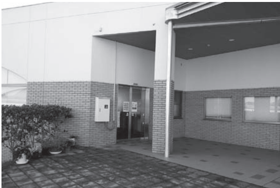
新規テナントが期待される道の駅滝宮
