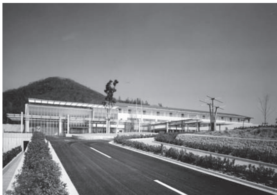
築18年が経過した陶病院
