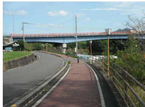
香川坂出丸亀自転車道線
