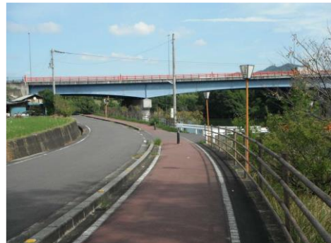
香川坂出丸亀自転車道線
