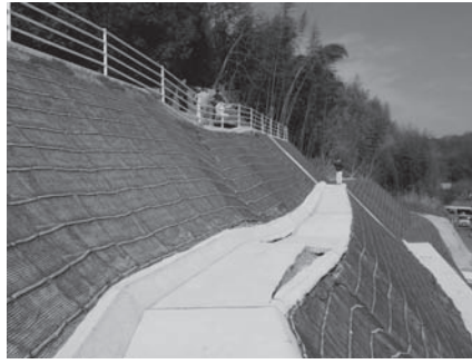
町道牛川堂谷線工事現場
