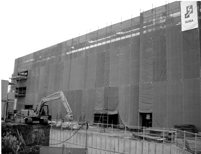
5月開所に向け工事が進む介護老人保健施設
