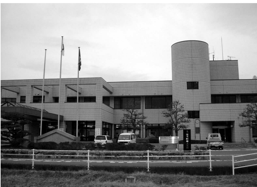
図書館の整備が行われる綾上支所
