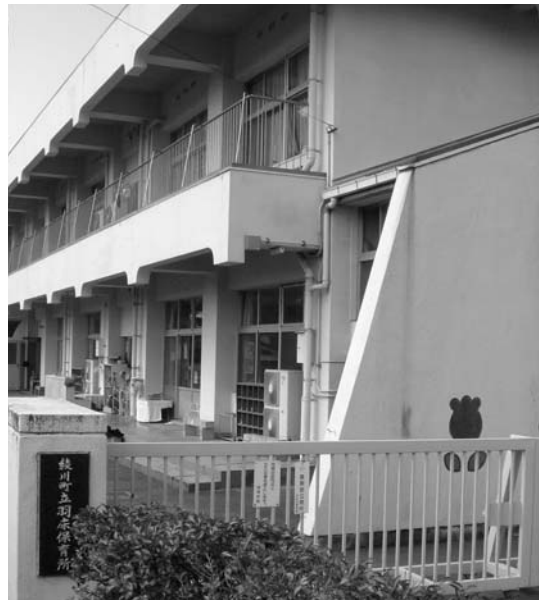
工事が待たれる羽床保育所
