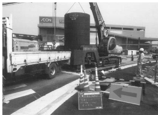
綾川町萱原での下水道工事現場
