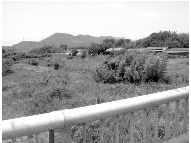
整備が待たれる北地区おけだ橋付近
