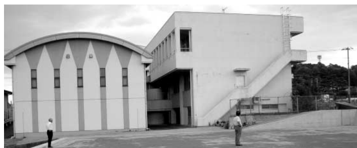
駐車場の拡張工事が終わった昭和公民館
