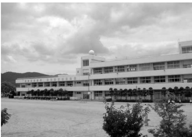
大規模改造工事をする滝宮小学校
