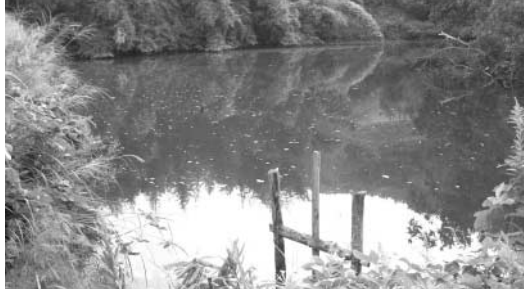
堤防改修を行う城方池
