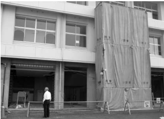
大規模改造工事中の滝宮小学校
