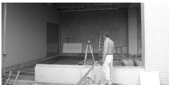
MRI室増築工事中の陶病院
