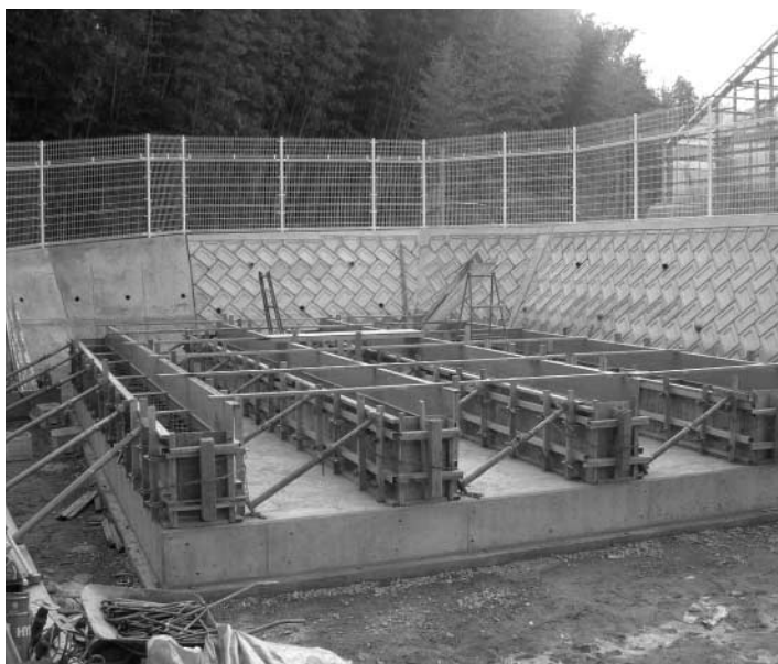
綾上中區配水池の工事現場(粉所 峯ヶ内)
