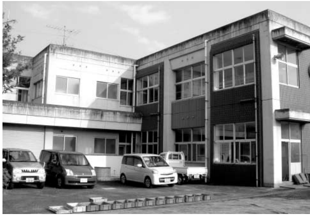
小規模多機能型居宅施設整備予定の旧羽床上小学校
