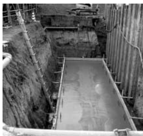
修理中の浄化槽
