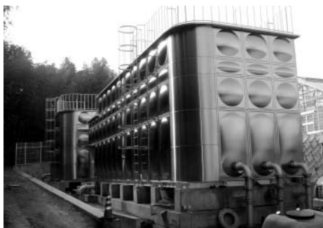
建設中の綾上中区配水池
