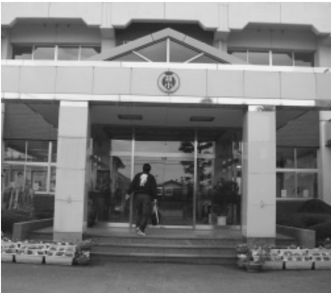
19年度に耐震工事を行う羽床小学校
