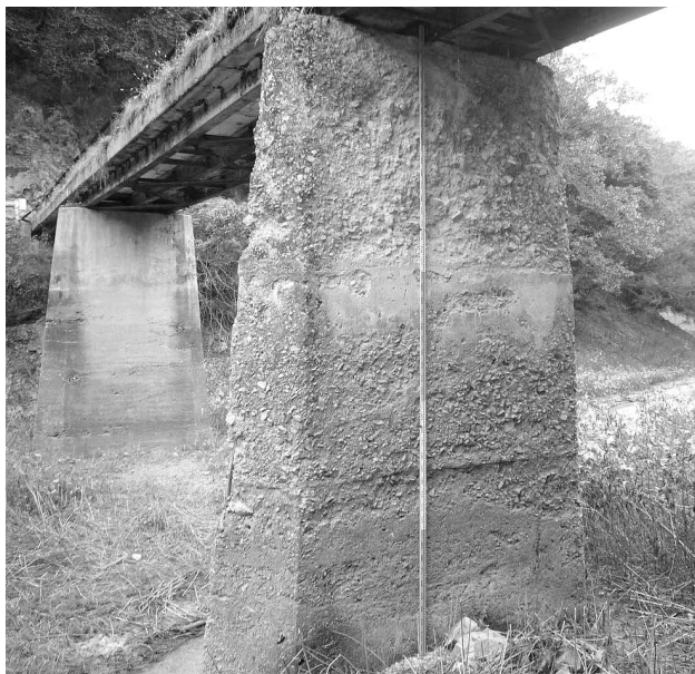
林道長柄線の橋梁補修
