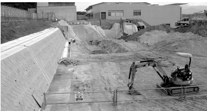
工事が進んでいる老健施設
