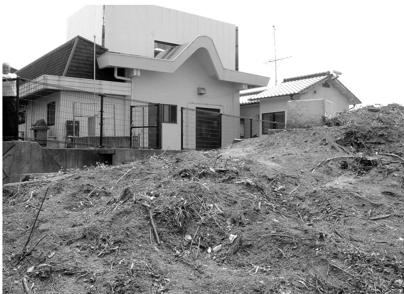
火葬場の造成工事現場
