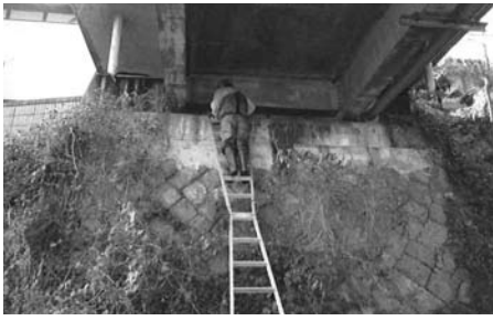
長田橋の橋梁点検
