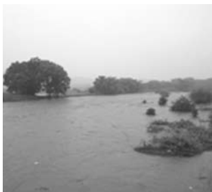
氾濫寸前の綾川河川羽床下地区
