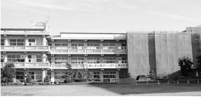
耐震工事中の綾上中学校
