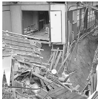
12号台風被災現場
