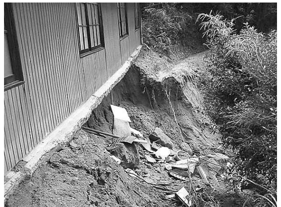
人家の周囲の土砂崩落
