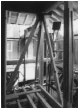
耐震改修工事
