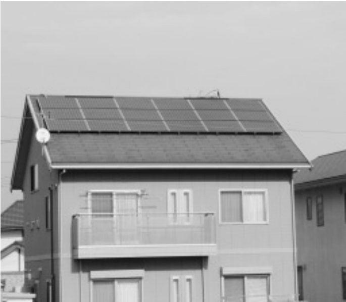
太陽光パネル設置住宅
