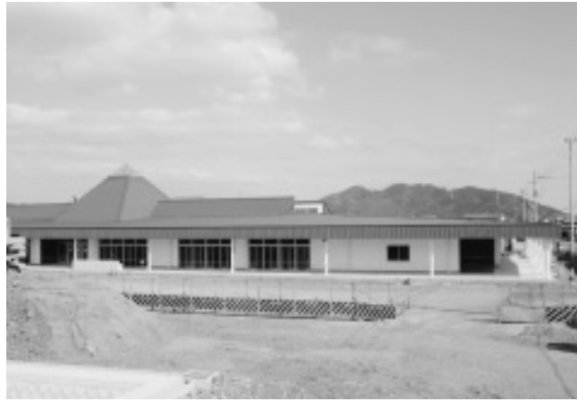
建築工事中の昭和保育所
