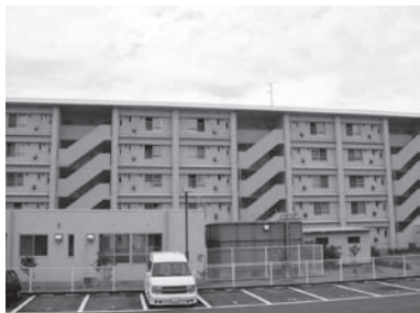
雇用促進住宅綾上宿舎
