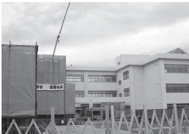
綾南中学校改築工事
