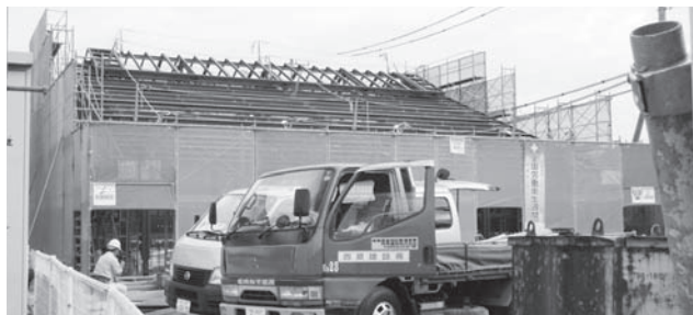
建設中の資料館
