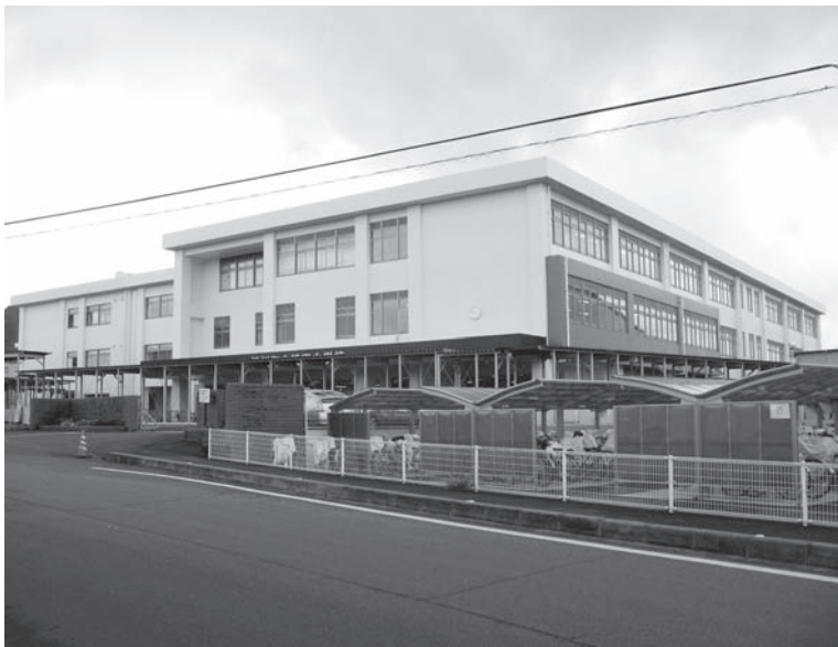
全体工事完了間近の綾南中学校
