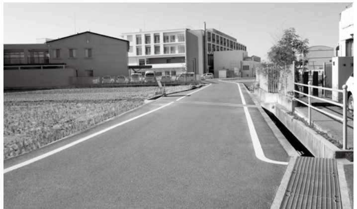
滝宮45工区下水管敷設工事箇所予定地
