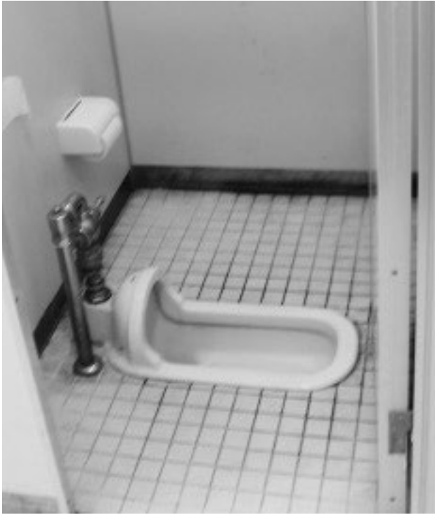
改修される陶小学校トイレ
