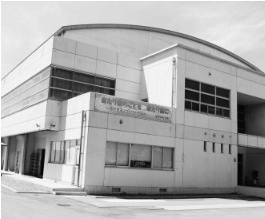
改修工事中の綾南中学校体育館
