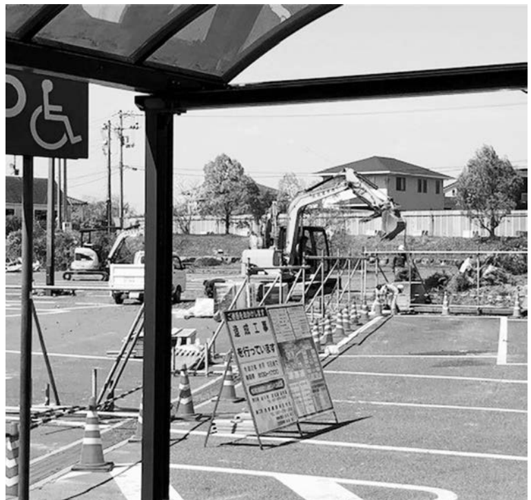
造成工事中の「道の駅滝宮うどん会館」
