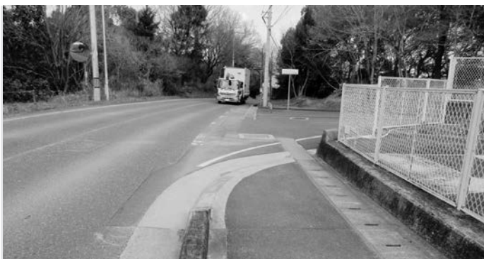
通学路の整備が必要な県道府中造田線
