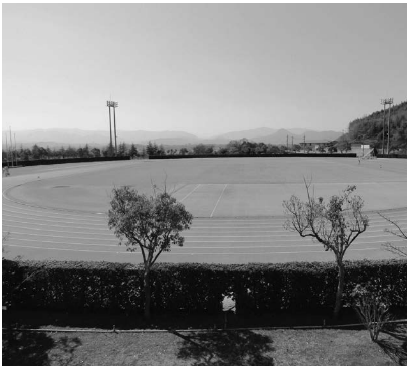
天然芝での改修工事が予定されている陸上競技場（綾川町総合運動公園）
