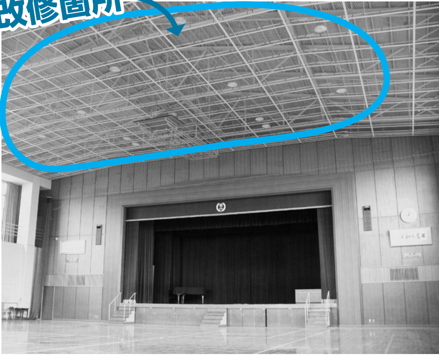
平成27年度に改修済みの羽床小学校体育館の天井
